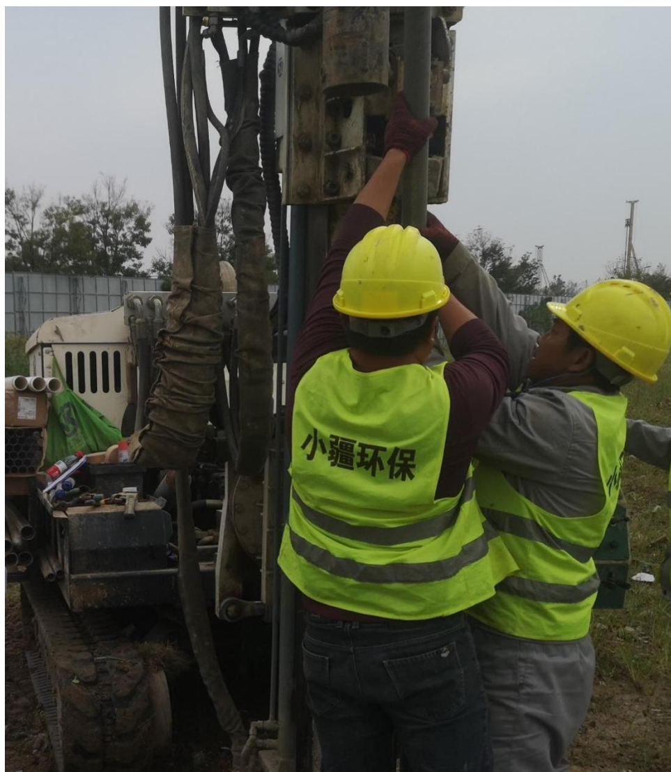
图5-6地下水监测井建设现场
